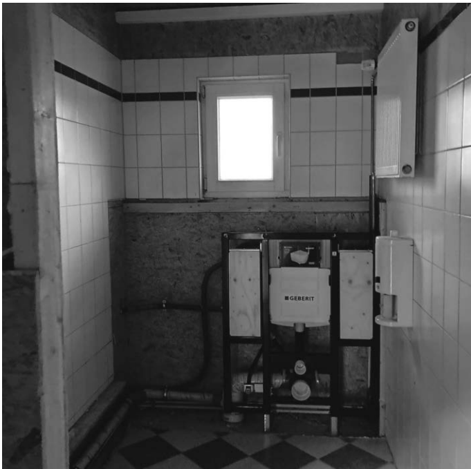
Der wesentlich größere Sanitärraum.
